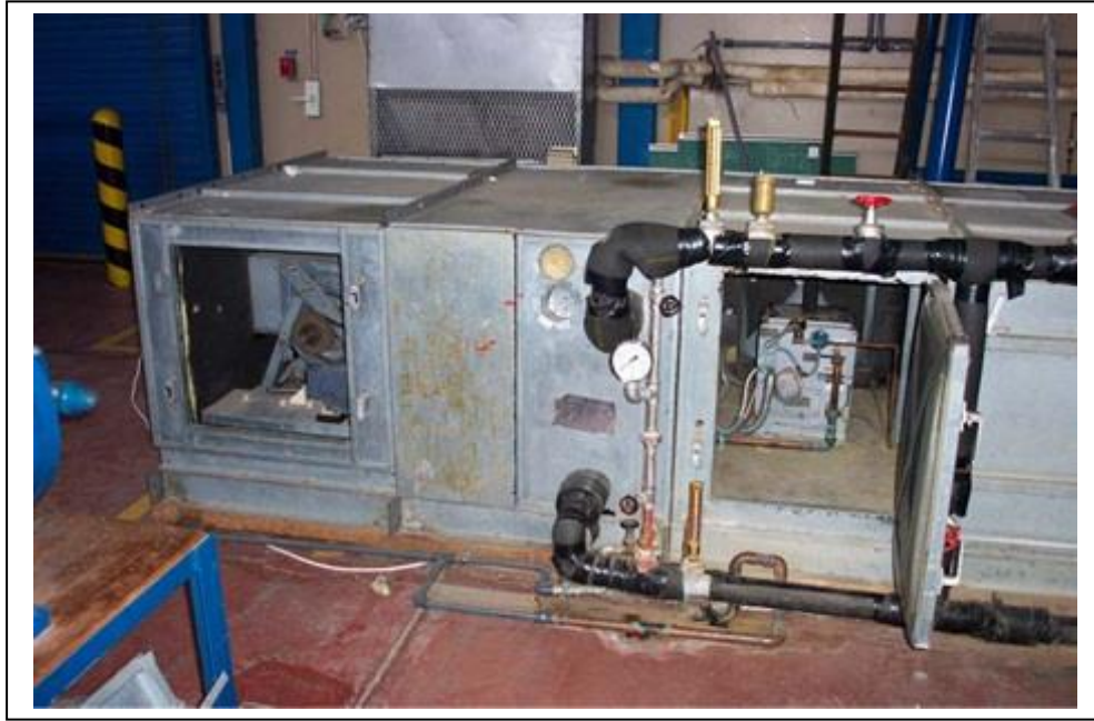
شكل (32): مرطب ببخار الماء وملف التبريد والسخان والمروحة
